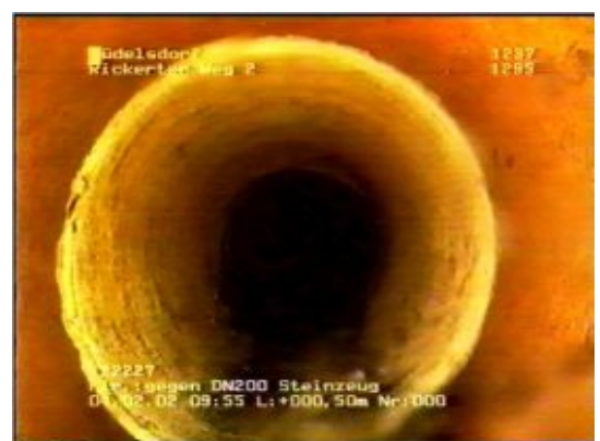
Kurzliner nach Sanierung im Jahr 2002
