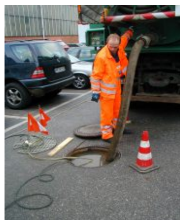
Herr Kobarg (WeVo) beim Befüllen der Leitung mit der S-2-Komponente
