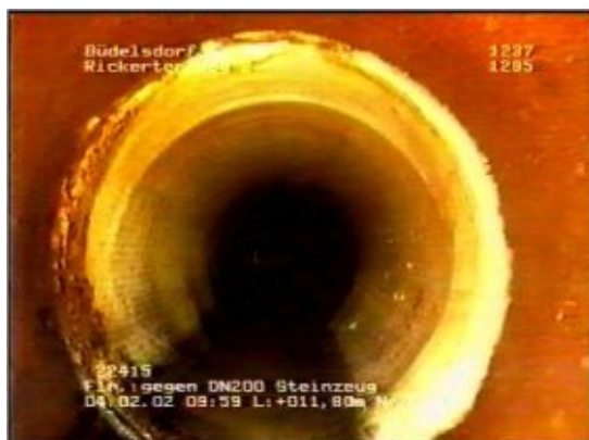
Kurzliner nach Sanierung im Jahr 2000
