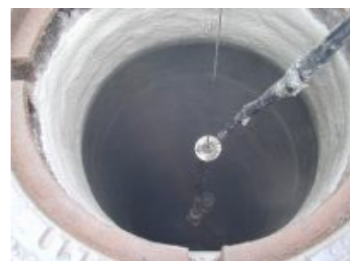
Ausschleudern des Schachtes mit dem besonders korrosionsbeständigen Mörtel Ergelit Kombina KS 2 B
