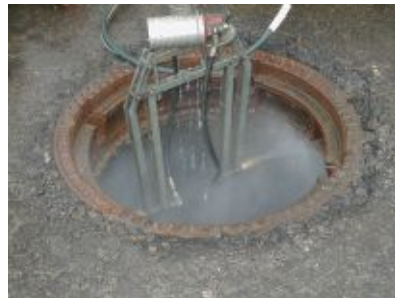
Reinigung des Schachtes mit der Hochdruckdüse TSSR
