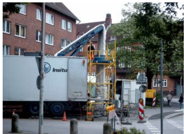
Einbringen eines großdimensionierten Liners in den Hauptkanal im Walkerdamm
