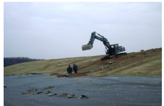
Großgerät auf der Deponie Alt Duvenstedt beim Einsatz. Dichtungsbahn im Vordergrund.
