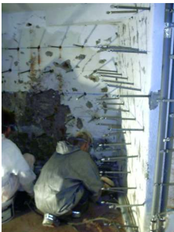
Kellerwand während der Sanierung mit den sichtbaren Injektionslanzen
