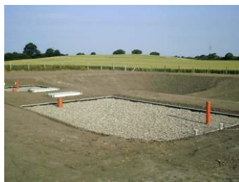
Sickerbecken/Bauwerke der Kläranlage Holzdorf
