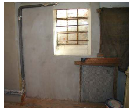
Kellerwand nach der Sanierung
