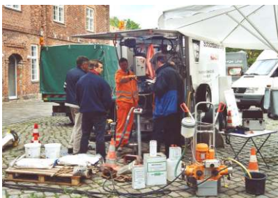
Vorführung einer Schachtsanierung
