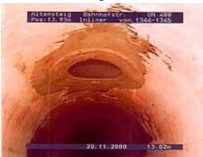
Abgeschlossene Stutzensanierung
