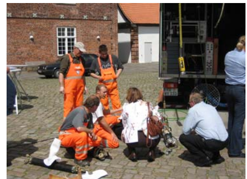
Vorfürhungen verschiedener Sanierungstechniken
