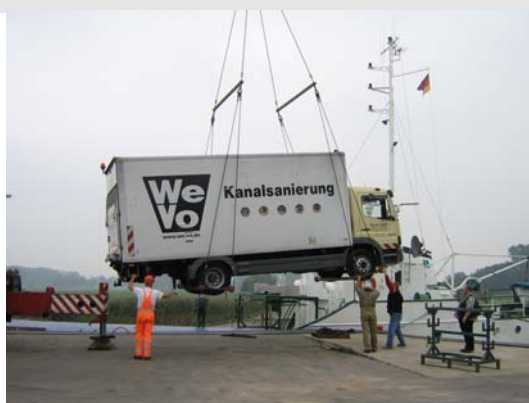
Verladung des Sanierungsfahrzeuges im Hafen.
