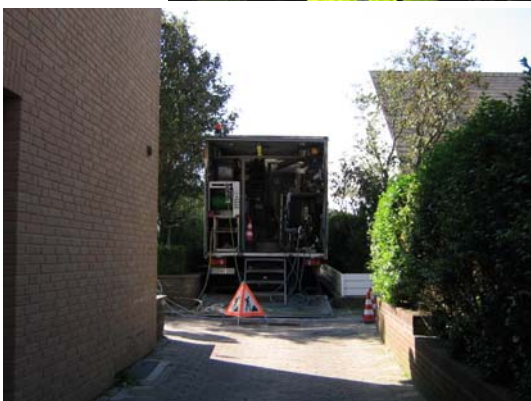
Sanierung auch in engsten Verhältnissen
