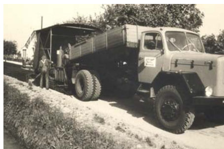
Baustelle Thielen in den 60er Jahren
