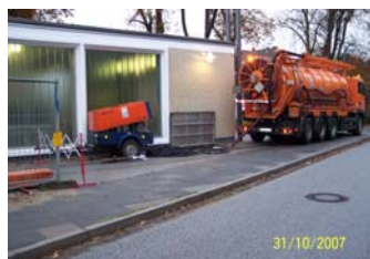
Saugwagen vor dem Fußgängertunnel
