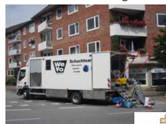
Sanierungseinheit im Einsatz
