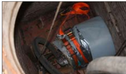
Liner bei Sanierung
