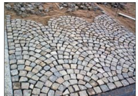
Neu in Segmentbögen verlegtes Basaltkleinpflaster
