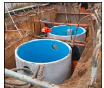
Einsatz der Grundwasserabsenkung
