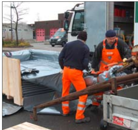
Der werksseitige Inliner DN 900 wurde einbaufertig auf die Baustelle geliefert.
