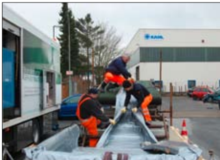
Mit einer Seilwinde wurde der Inliner in die zu sanierende Haltung eingezogen.
