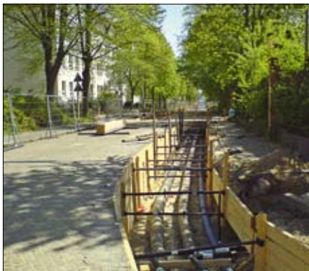
Verbauter Rohrgraben im historischen Bereich
